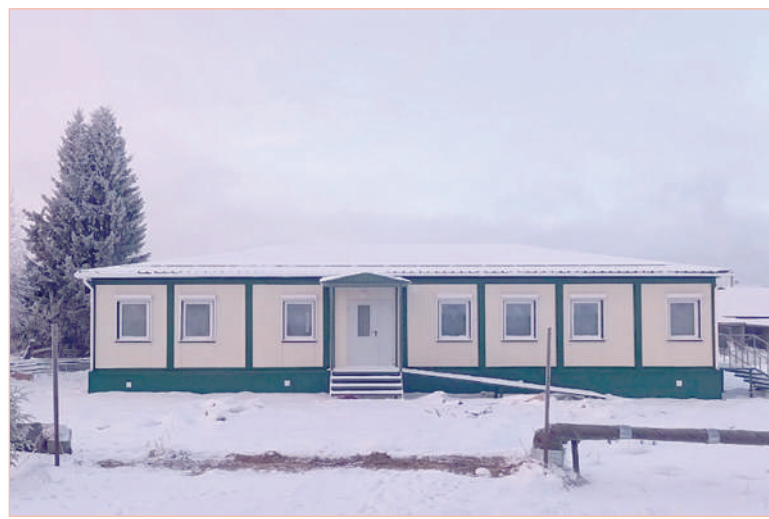
Ставшая знаменитой амбулатория в Ломоватке. Сначала ее очень долго строили, а теперь, видимо, придется быстро сносить из-за нарушений технологии.
